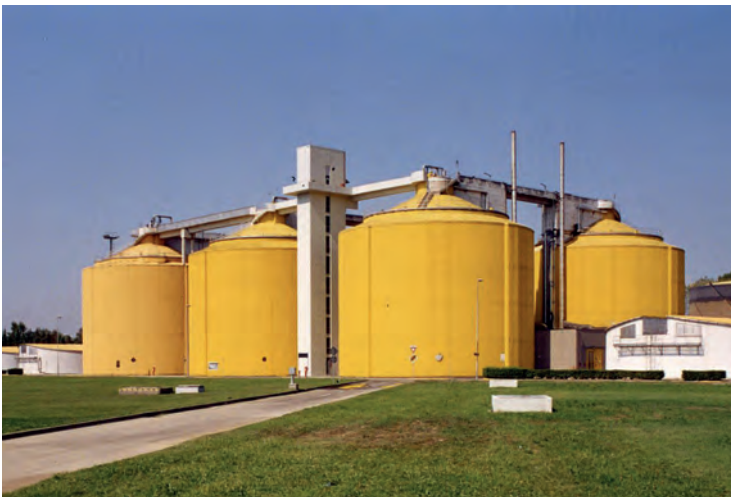
Fig. 8.1. Esempio di digestore anaerobico di fanghi di depurazione.
