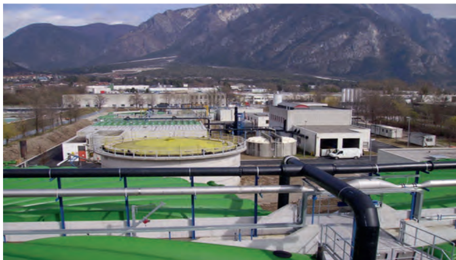
Fig. 5.1. Impianto di depurazione di Tolmezzo (Friuli Venezia Giulia).
