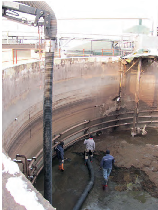
Fig. 12.2. Azioni di svuotamento, pulizia e rimozione dei sedimenti da un digestore anaerobico.
